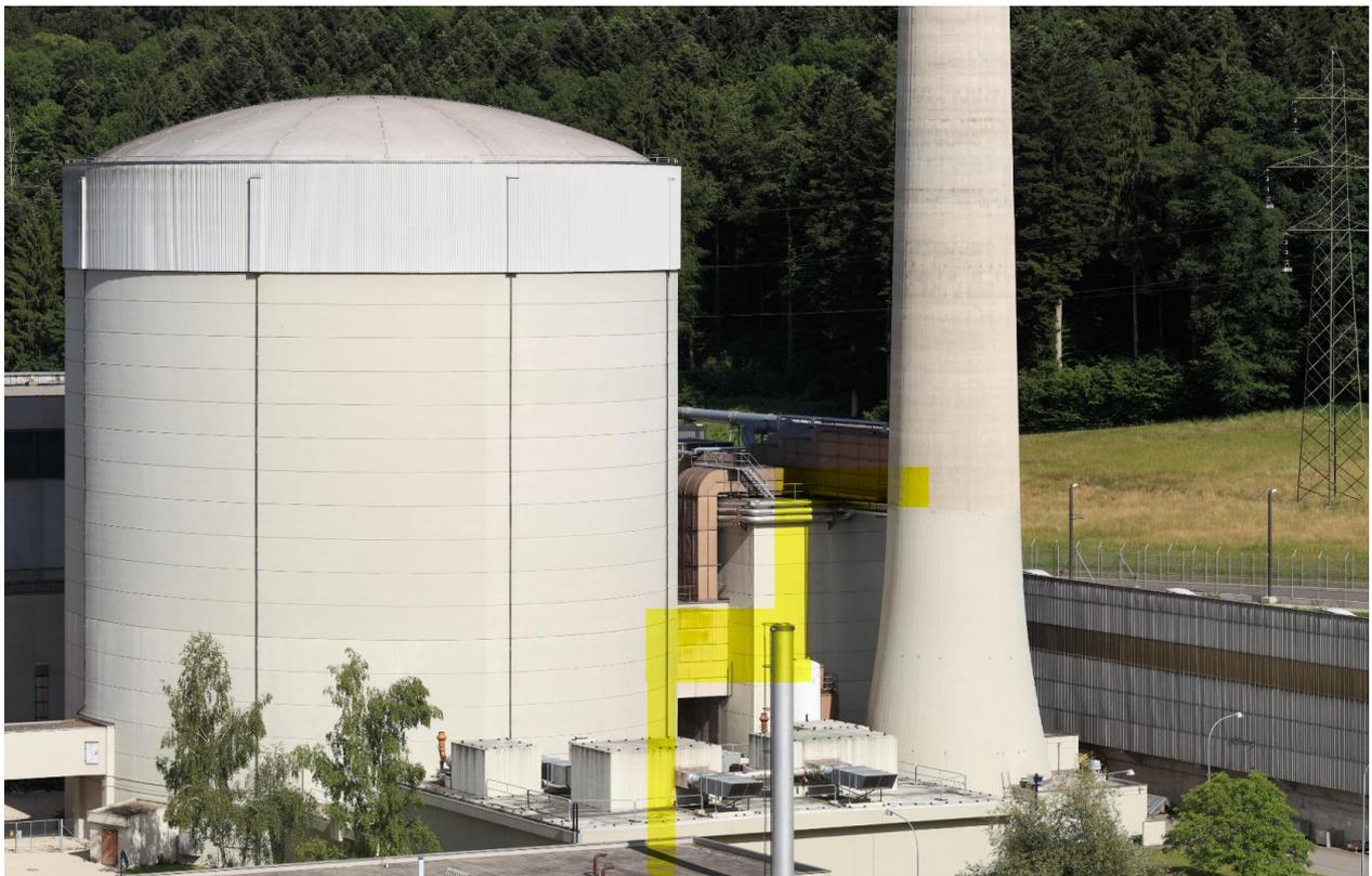
**Fig. 2 KKM von Westen mit Pfad Containment Druckentlastung in Hochkamin (Foto M. Kühni, 2011)**
