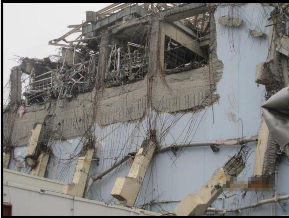
Fig. 6 Gebäudeschäden nach Wasserstoff-Explosion in Fukushima Daiichi<sup>18</sup>
