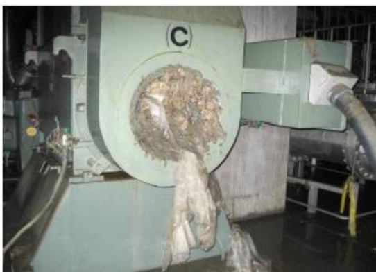
Abb. Verstopfung in Fukushima, Japanischer Regierungsbericht, III-46. 8
