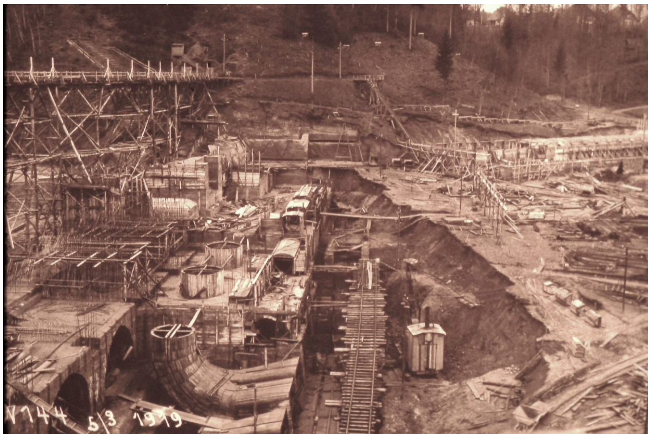
Foto: Baustelle Damm im Bereich Maschinenhaus 92 :
