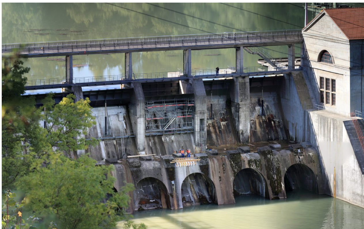
Foto: Reparaturen am gealterten Wehrteil und Abfallboden, 6. 9. 2011
