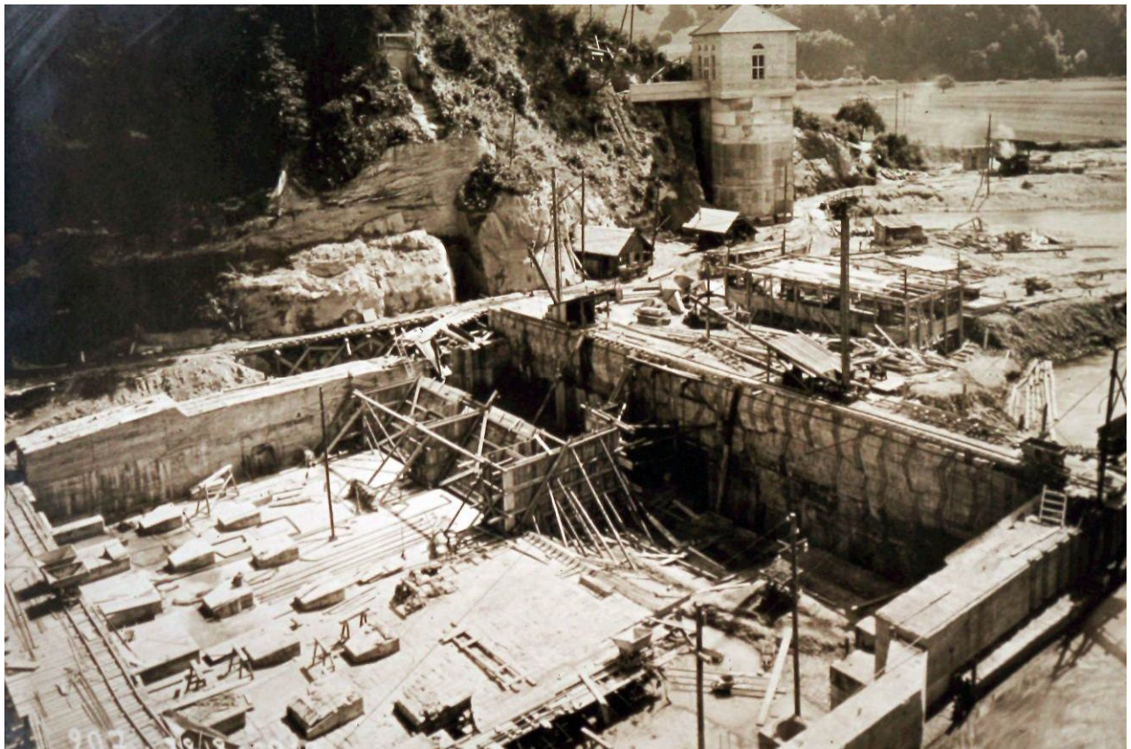
Figure 3 : Unterer Abfallboden mit erster Schalung oberer Abfallboden. Foto: Staatsarchiv Bern, N P. Böhm 15
