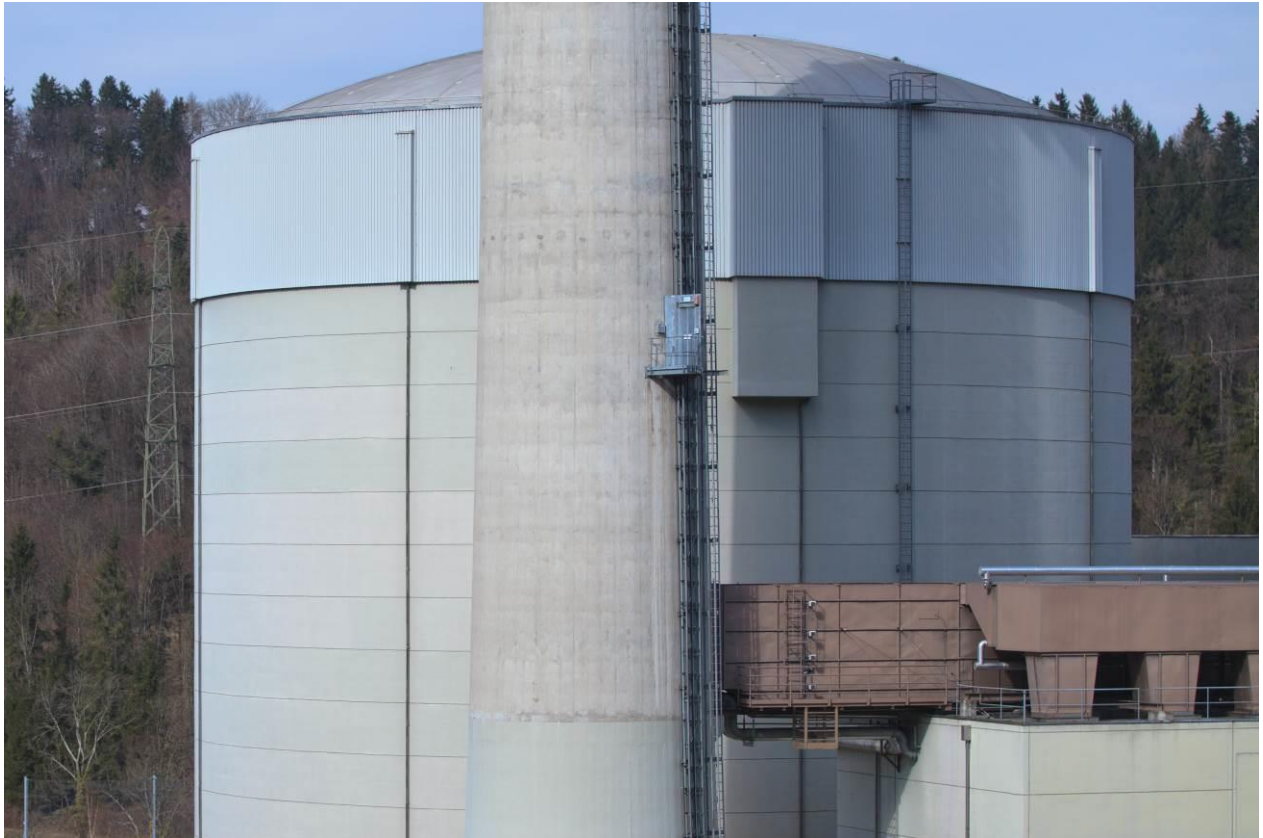
Figure 11 Brücke vom Aufbereitungsgebäude zum Abluftkamin
