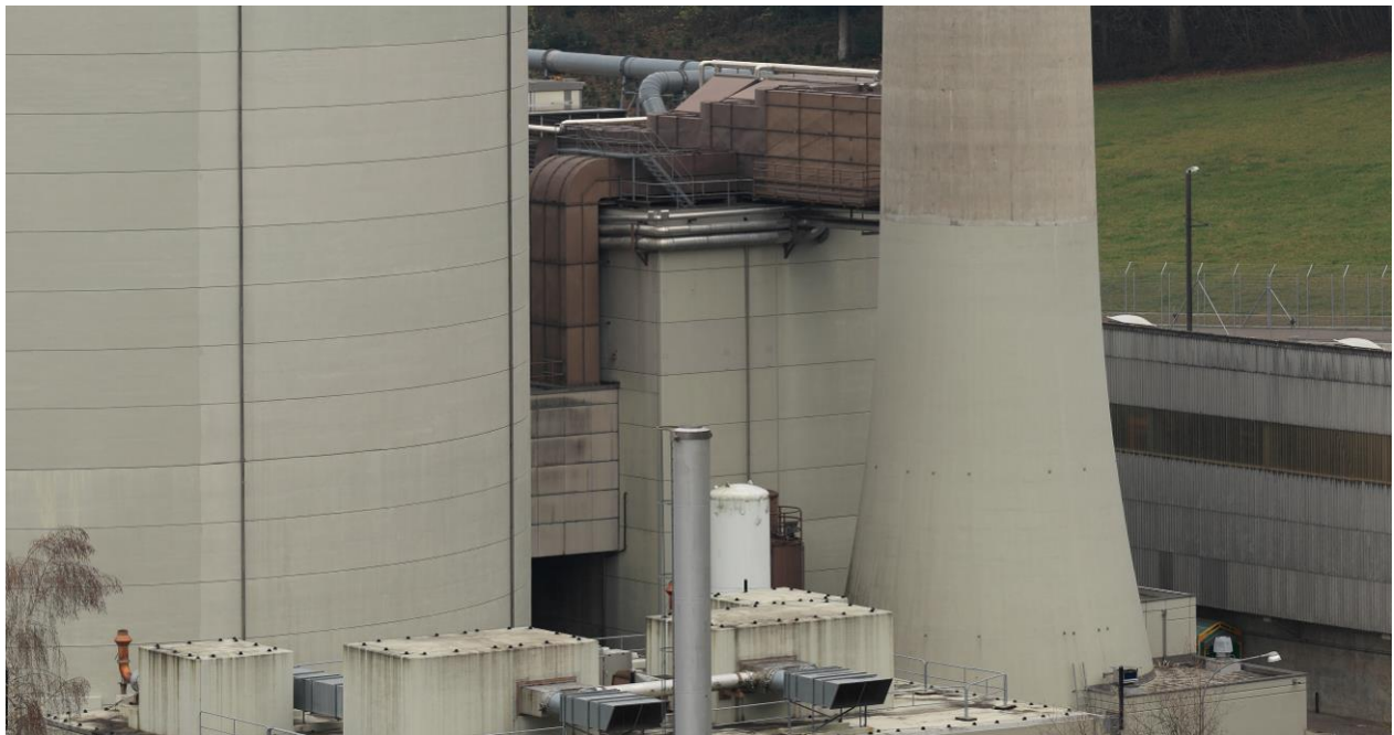
Figure 3 Einblick auf Aufbereitungsgebäude und Gebäudebrücken zu Reaktorgebäude und Kamin
