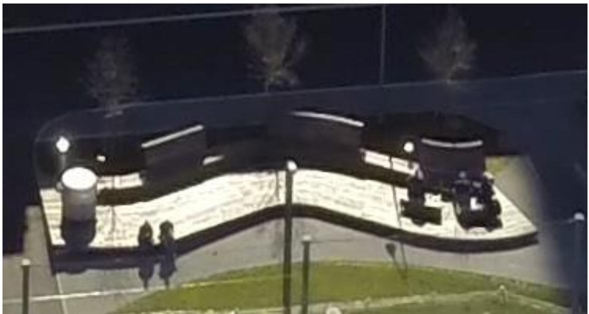
Abbildung 3 Ausschnittvergrößerung Holzplattform und Sitzbank mit eingezwängter Einspeisestelle (tonnenförmig, links)
