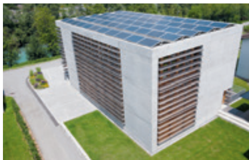
Das Bürohaus Cavigelli in Ilanz produziert mehr als doppelt so viel Energie, als es braucht. Projekt: Vincenz Weishaupt Architekten
