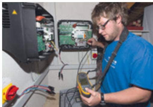
Einmal installiert muss auch die Steuerung der Anlagen funktionieren.
