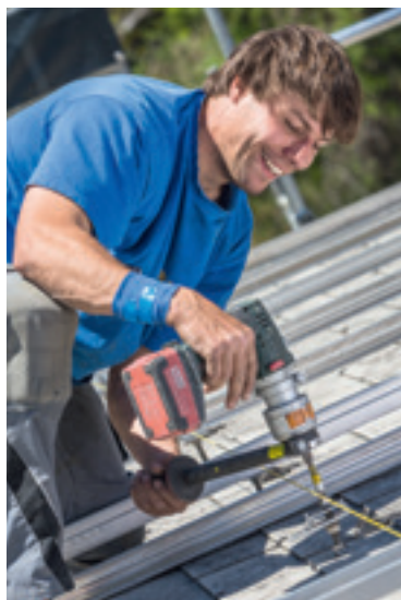
Solaranlagen werden meist von A bis Z selbst aufgebaut.
