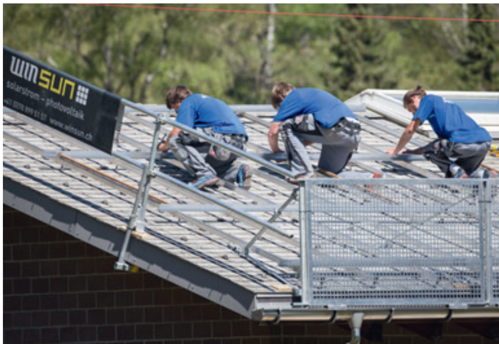
Drei von inzwischen mehr als vierzig Winsun-Angestellten montieren Solarpanels auf einem Walliser Hausdach.
