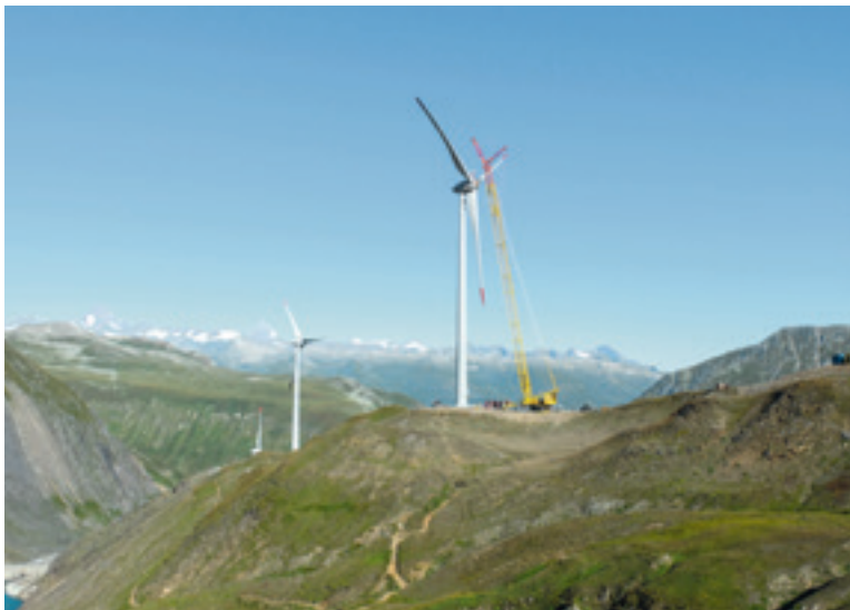
Bau des Windkraftwerks auf dem Gries. Foto: SwissWinds / Olivier Maire
