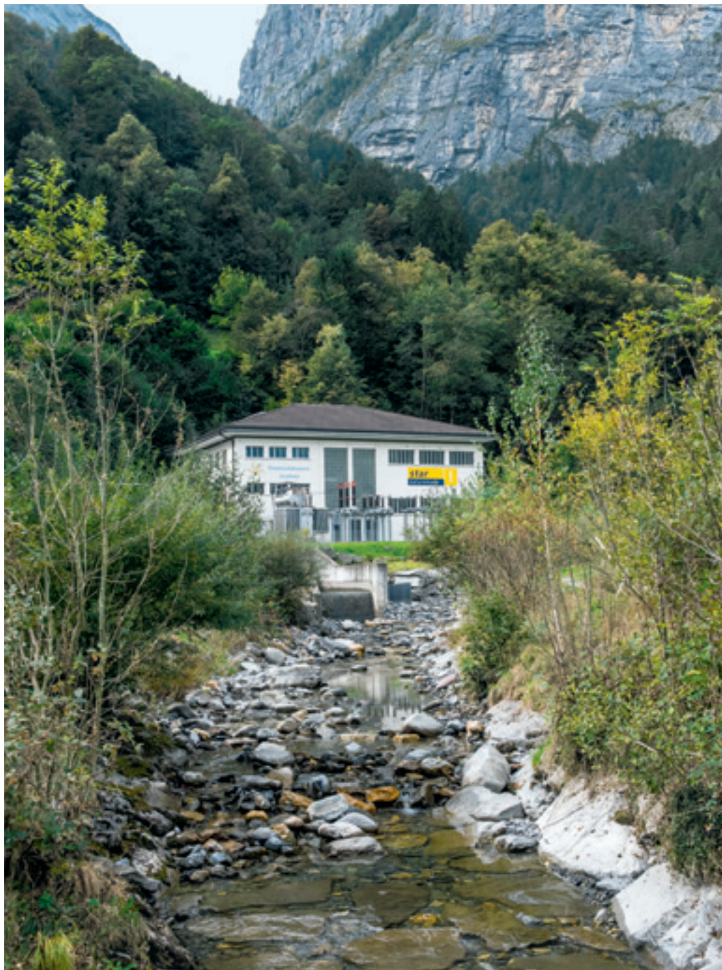
Die Turbinen in der Zentrale Ripshausen der Gemeindewerke Erstfeld liefern übers Jahr gerechnet mehr Strom, als die «Energistadt» selbst verbraucht.
