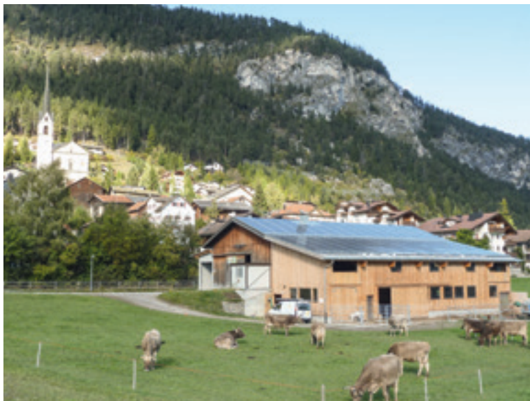
Das Solarkraftwerk auf dem Stall der Familie Negrini in Alvaneu produziert Strom für 14 Haushalte. Projekt: Solarspar
