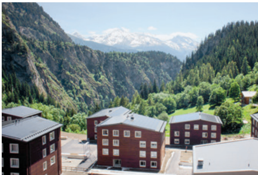
Sonne, Erdspeicher und Abwasserwärme liefern für die fünfzig Wohnungen und das Hallenbad der Reka-Siedlung in Blatten achtzig Prozent der Energie. Projekt: Lauber Iwisa
